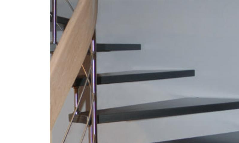
Page 2: Escalier cintré avec balustrade montante sur les deux côtés. Marches en hêtre, main-courante laquée en couleur, barreaux et poteaux en inox.
