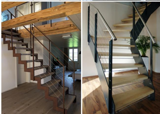
**Généralités.** Escaliers à limons en bois massif tels que hêtre, chêne, frêne, sapin et autres. Exécution sans ou avec contre-marches. Projet et construction sur mesure dans notre atelier par nos collaborateurs spécialisés. Variante: Limons en métal avec marches en bois massif et main-courante à votre choix.
